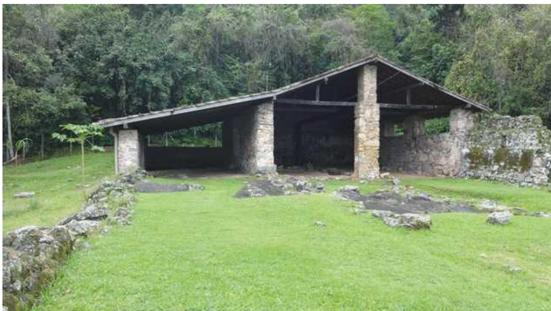
Figura 9: Pavilhão Saia , três lanços de telhado. Foto: Autor, 2013.
