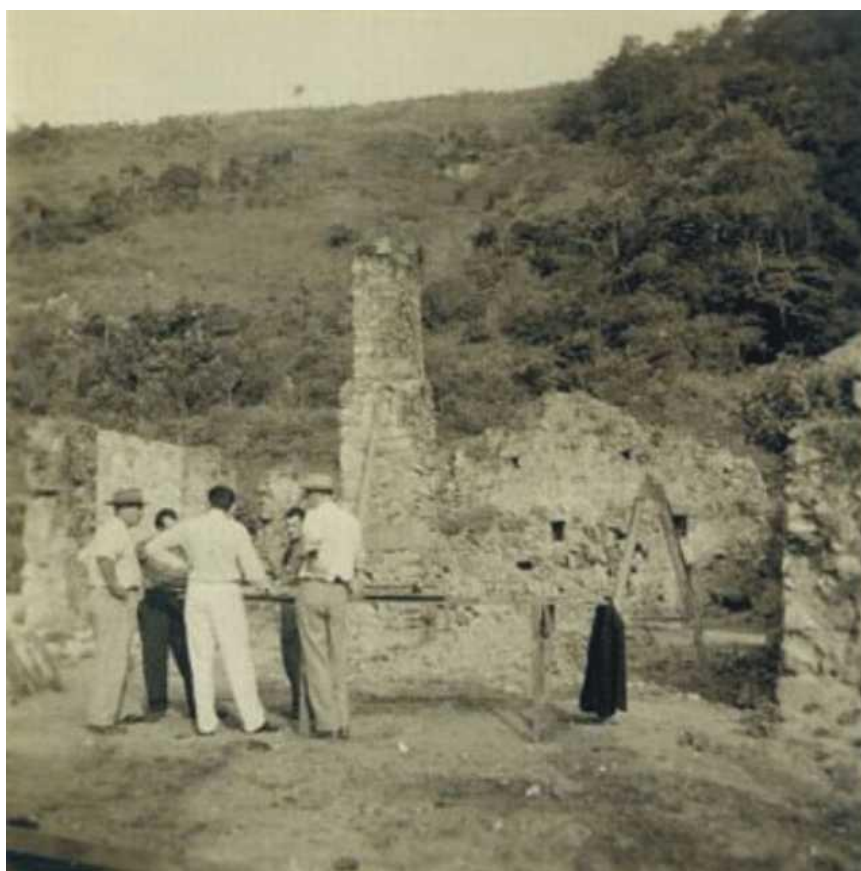
Figura 8: Consolidação pilar central. Fonte: Caderno de Obras 1963-1966, Luis Saia, Acervo fotográfico IPHAN/SP.
