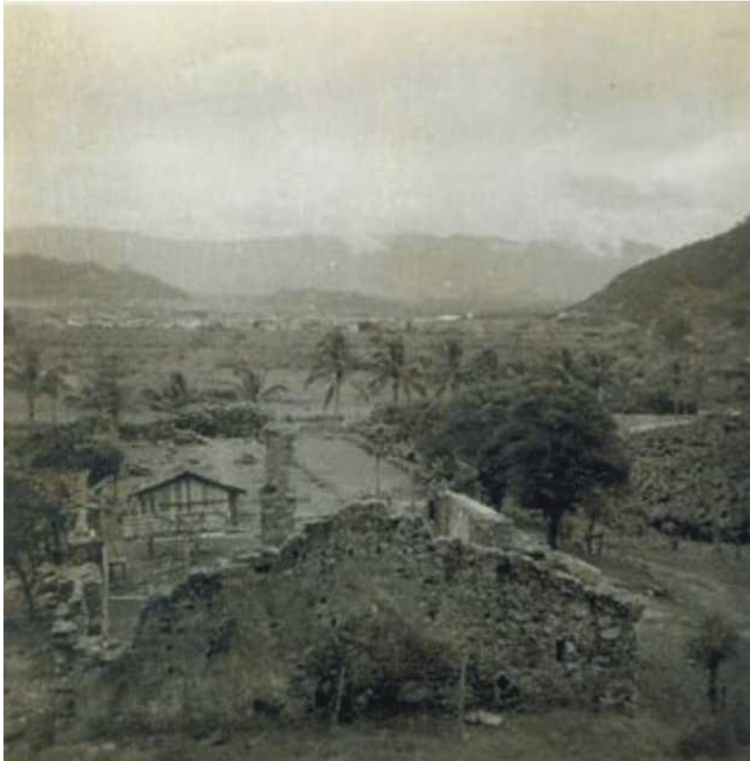
Figura 6: Vista para o entorno.
